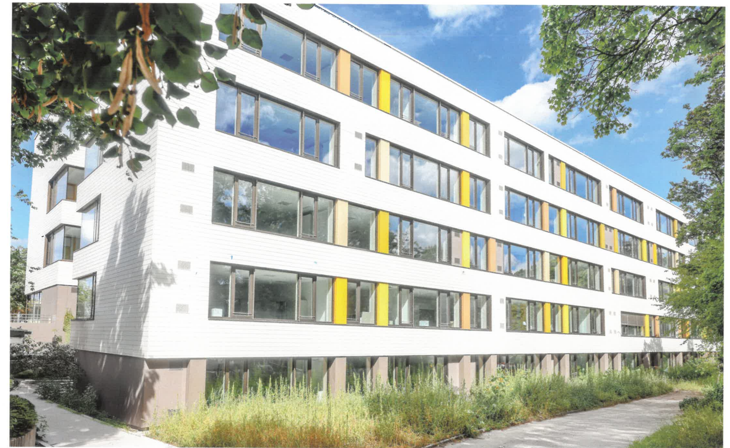
Justus-von-Liebig-Gymnasium, Neusäß: Das Schulgebäude und der Neubau Sporthalle und Mensa wurden in einem hohen energetischen Standard generalsaniert bzw. errichtet Abb.: Julia Pietsch
